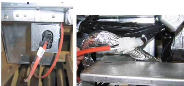
Obrázek 6: Upevněte dvoukolíkové bílé konektory a připojte černý konektor k výstupní skříni podle obrázku. * Povšimněte si, že poloha černého konektoru se může lišit od fotografie.
